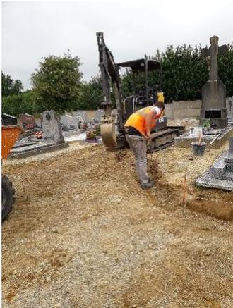
Une seconde tranche de travaux concerne l'entourage des tombes. Ces travaux se feront avec les familles, il s'agit d'enlever le sable existant entre les emplacements, mettre un "Bidim" et combler avec du gravier pour obtenir un revêtement moins accessible aux mauvaises herbes et plus harmonieux.
