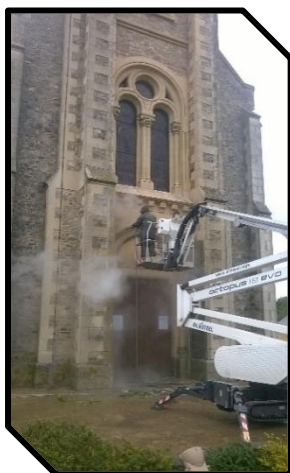
Nettoyage façade église
