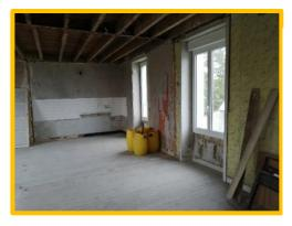
Les travaux du logement se poursuivent progressivement. Les artisans sont intervenus pour électricité, pose placo plâtre et la chappe par l'agent communal. Il reste la finition de l'électricité, la peinture et la pose du parquet.
