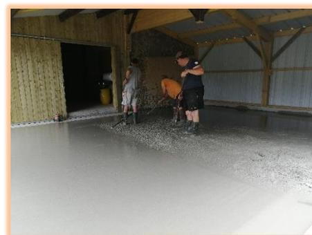
*Ecoulement dalle en béton*
